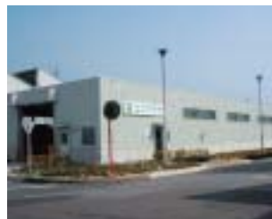
エコプラザ(安城製作所)
